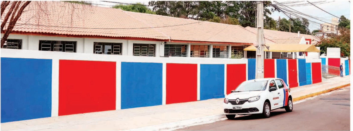
Escola Municipal Professor Alcides Ramos, situada no Núcleo Osmar Guaracy Freire, é uma das unidades educacionais do município em fase final de obras
